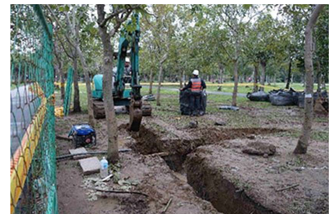
写真3 連続溝土壌改良区のトレンチの掘り取り状況 左側の樹木が連続溝(トレンチ工法)試験対象木。トレンチは幹より1m離してバックホーで掘削
